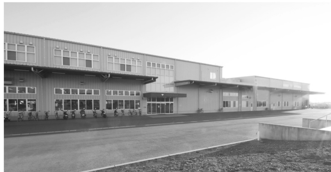
▲18(平成30)年6月に完成した城野印刷所(益城町広崎)の本社・工場
